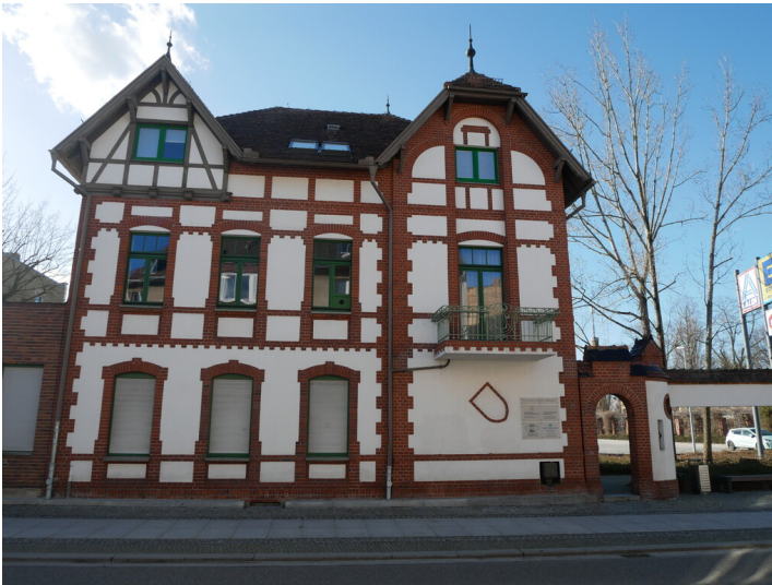
Gedenktafel, Umfassungsmauer Gas- und Elektrizitätswerk Finsterwalde und Kontor-/Wohnhaus Fotograf/Urheber: Franz Dietzmann
