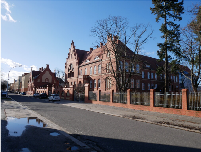
Realgymnasium Fotograf/Urheber: Franz Dietzmann
