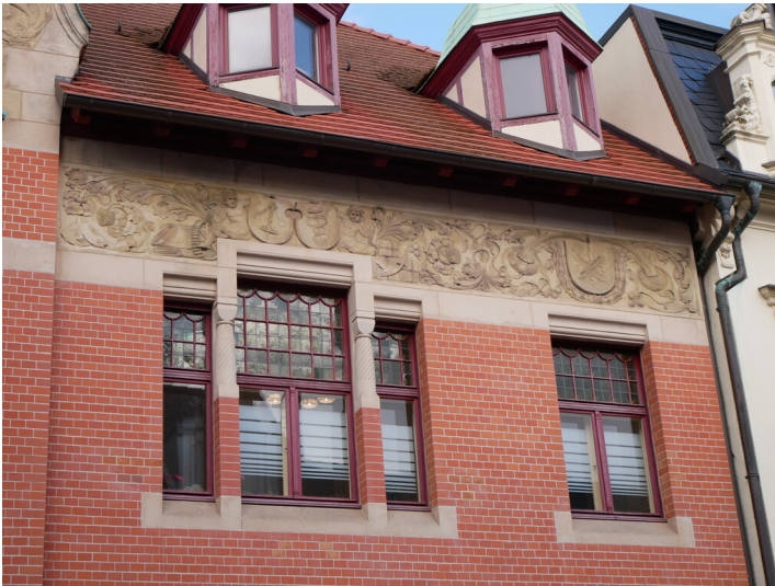
Wohnhaus des Tuchfabrikanten Max Koswig Fotograf/Urheber: Franz Dietzmann
