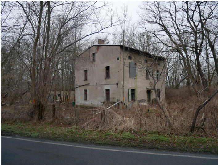
Gebäude der Beutesitzer Kohlenwerke Fotograf/Urheber: Franz Dietzmann
