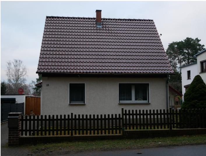
Bergarbeitersiedlung Alte Heerstraße Fotograf/Urheber: Dr. Barbara Kündiger
