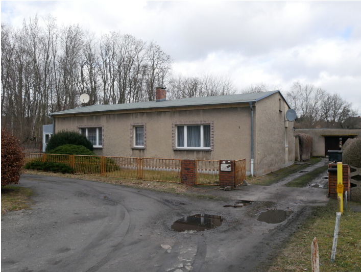
Kontorgebäude der Hedwigshütte Fotograf/Urheber: Kaja Boelcke
