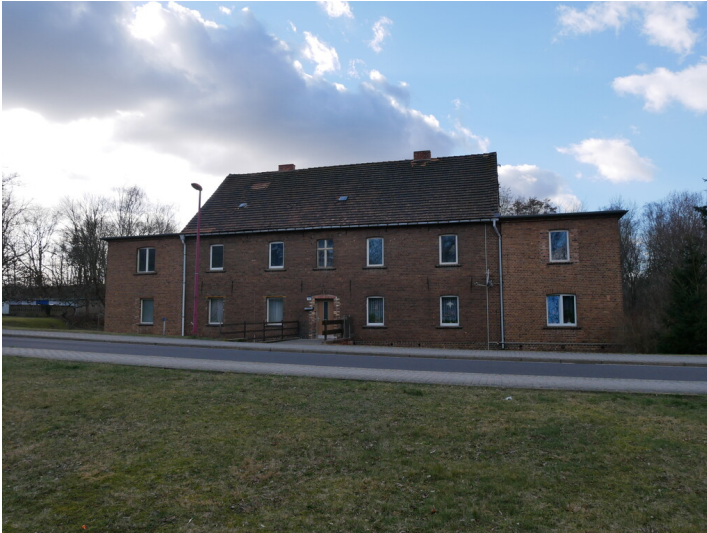
Wohngebäude westlich des Glashüttenareals Robert Hirsch Fotograf/Urheber: Kaja Boelcke
