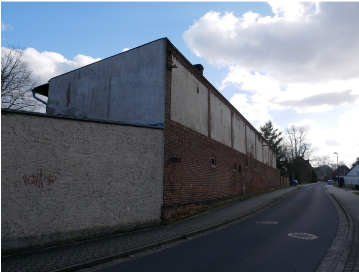
Wirtschaftsgebäude der Glashütte Gebrüder Hirsch Fotograf/Urheber: Kaja Boelcke
