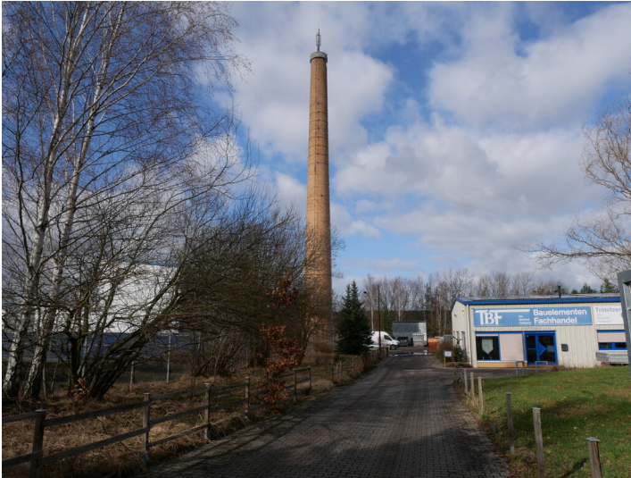
Heizwerk Tröbitz Fotograf/Urheber: Kaja Boelcke
