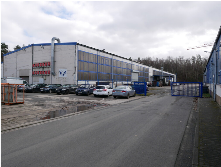
Halle 7 Fotograf/Urheber: Kaja Boelcke
