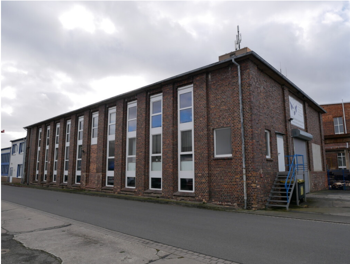
Magazin der Brikettfabrik Hansa Fotograf/Urheber: Kaja Boelcke
