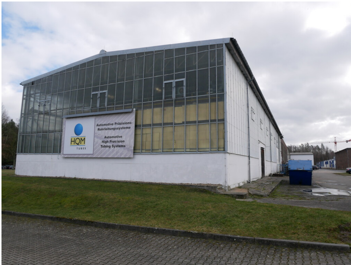
Mechanische Werkstatt der Brikettfabrik Hansa Fotograf/Urheber: Kaja Boelcke
