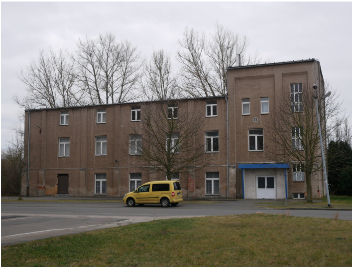
Kühlhaus der Brikettfabrik Hansa Fotograf/Urheber: Kaja Boelcke
