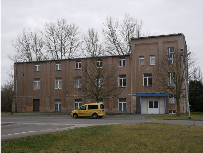
Kühlhaus der Brikettfabrik Hansa Fotograf/Urheber: Kaja Boelcke
