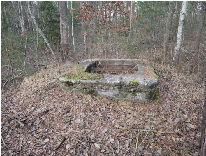
Schachtanlagen der Erika Fotograf/Urheber: Franz Dietzmann
