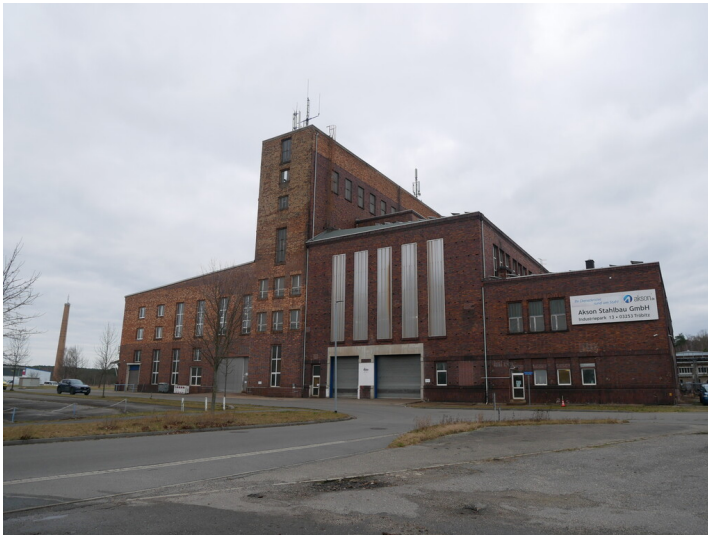
Kraftwerk Tröbitz Fotograf/Urheber: Kaja Boelcke
