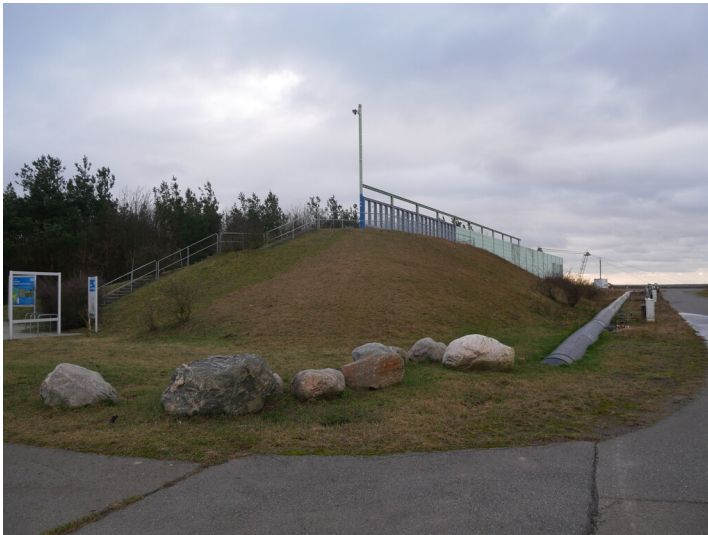
Schutzbauwerk Grießen Fotograf/Urheber: Kaja Boelcke
