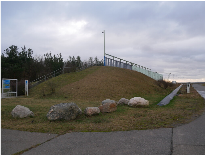
Schutzbauwerk Grießen Fotograf/Urheber: Kaja Boelcke
