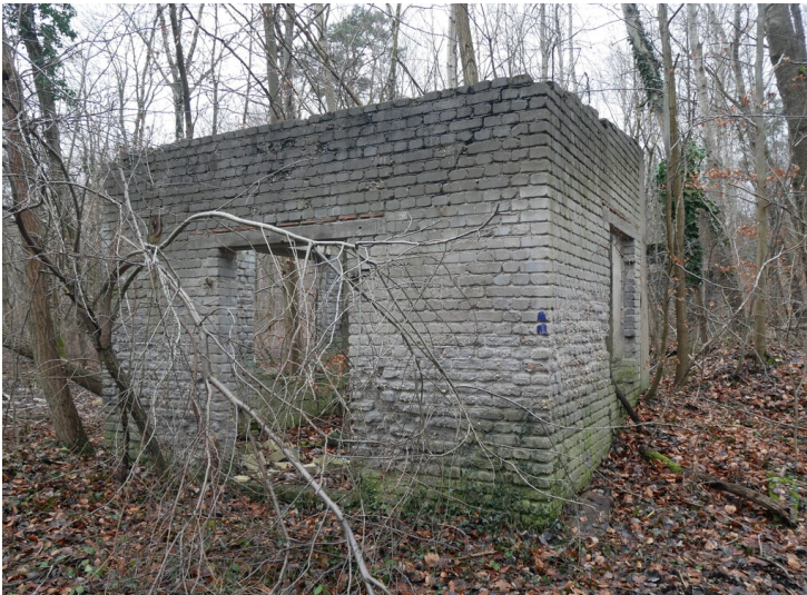
Hochseilbahn der Grube Pauline Fotograf/Urheber: Tanja Trittel
