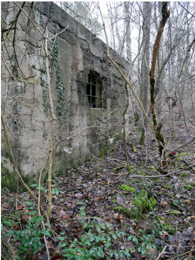
Waagestation der Grube Pauline Fotograf/Urheber: Kaja Boelcke
