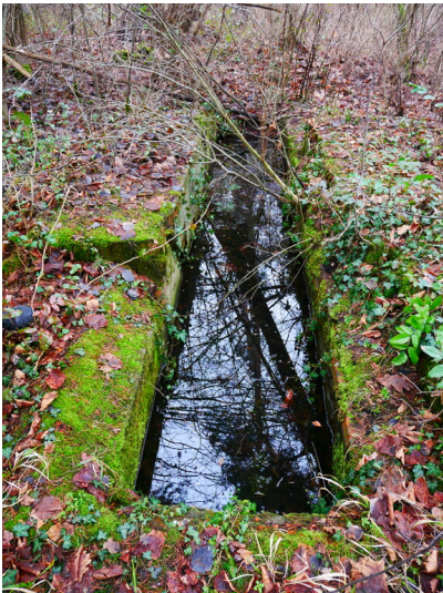
Fahr- und Förderschacht Margarethe Fotograf/Urheber: Kaja Boelcke
