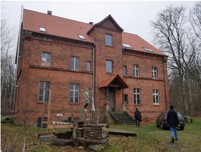
Beamtenwohnhaus mit Kontor der Grube Pauline Fotograf/Urheber: Tanja Trittel
