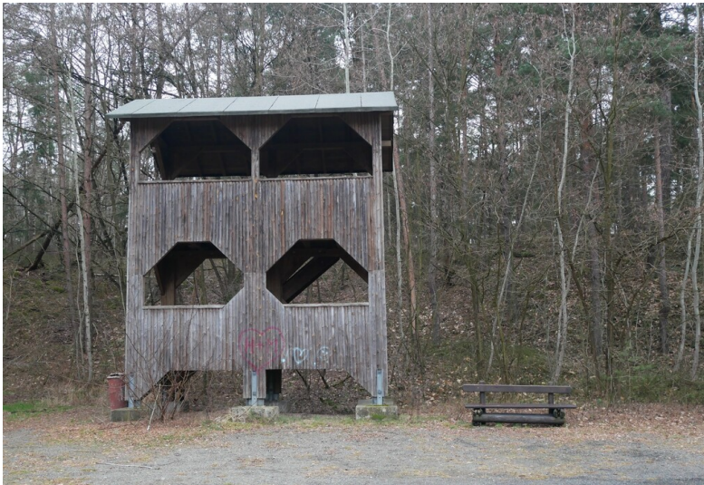
Aussichtsturm Restloch 124 Fotograf/Urheber: Kaja Boelcke
