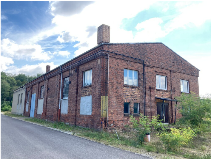
Guss- und Turbinenschleiferei Zentralwerkstatt Fotograf/Urheber: Kaja Boelcke
