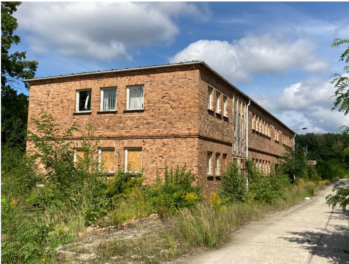
Bürogebäude Zentralwerkstatt Welzow Fotograf/Urheber: Kaja Boelcke
