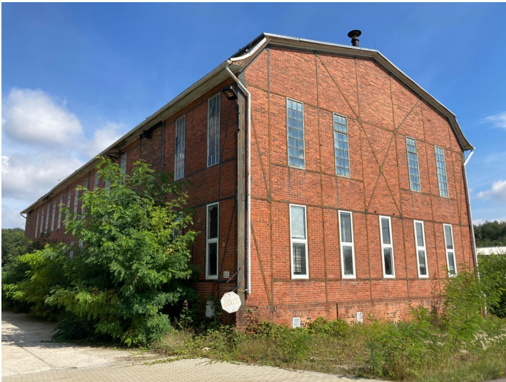
Magazin Zentralwerkstatt Welzow Fotograf/Urheber: Kaja Boelcke
