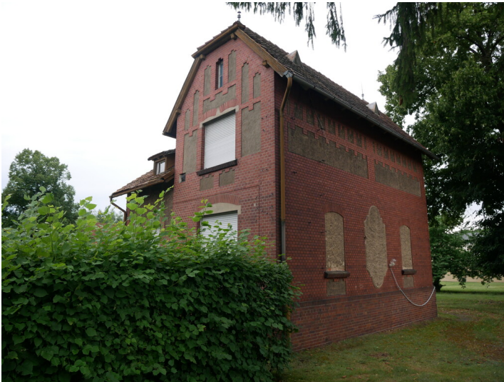
Direktorenvilla Gaswerk Fotograf/Urheber: Franz Dietzmann
