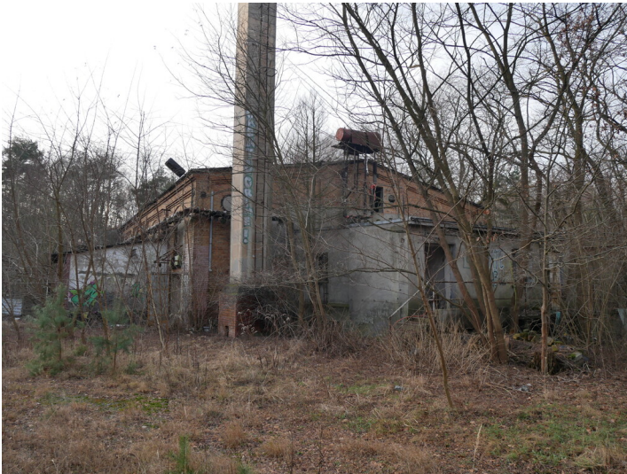
Kesselhaus der Grube Conrad: 1860-1959 Fotograf/Urheber: Franz Dietzmann
