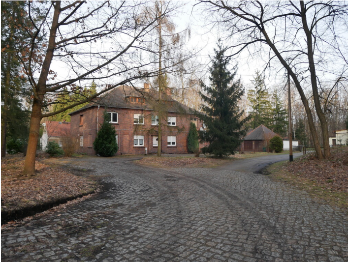
Waagehaus der Grube Conrad Fotograf/Urheber: Franz Dietzmann
