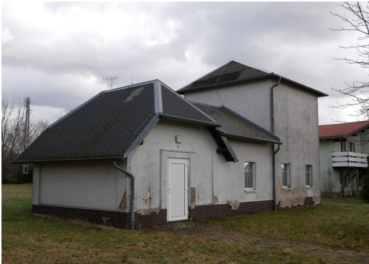
Wasserwerk Domsdorf Fotograf/Urheber: Kaja Boelcke
