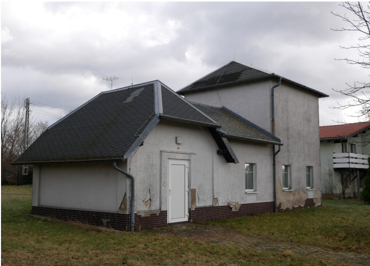
Wasserwerk Domsdorf Fotograf/Urheber: Kaja Boelcke
