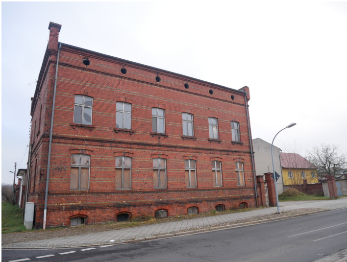
Schlachthof Forst Fotograf/Urheber: Tanja Trittel
