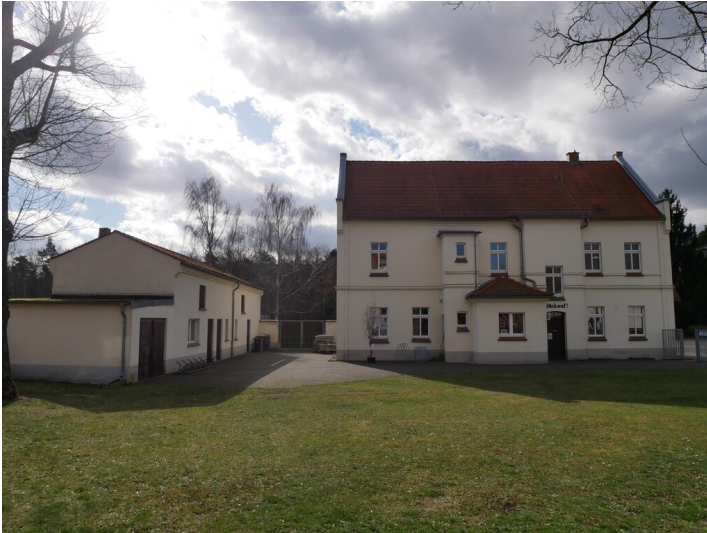
Direktorenhaus und Verwaltung Fotograf/Urheber: Kaja Boelcke
