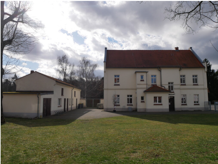
Direktorenhaus und Verwaltung Fotograf/Urheber: Kaja Boelcke
