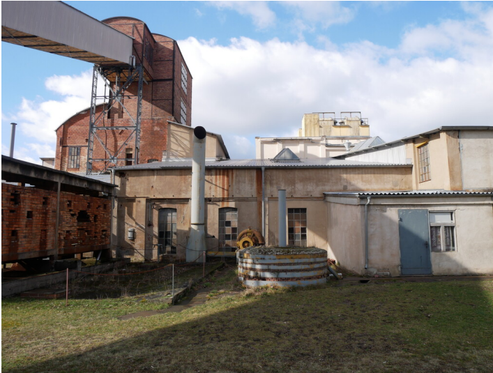
Pumpenhaus der Brikettfabrik Louise Fotograf/Urheber: Kaja Boelcke
