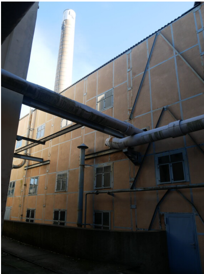
Kesselhaus Fotograf/Urheber: Tanja Trittel
