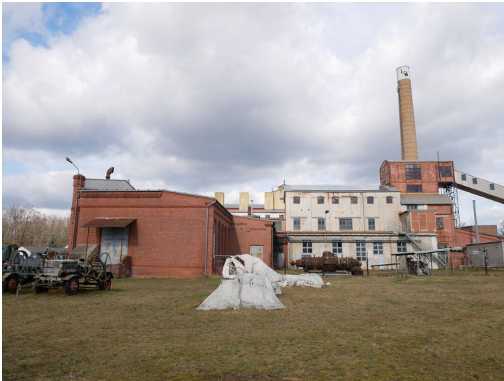
Pressenhaus II der Brikettfabrik Louise Fotograf/Urheber: Kaja Boelcke
