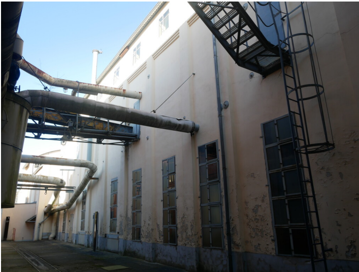
Trockendienst der Brikettfabrik Louise Fotograf/Urheber: Tanja Trittel
