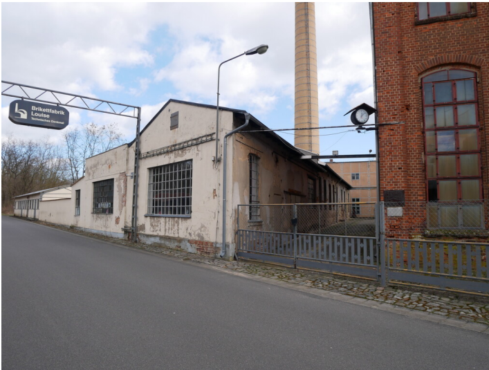
Formzeugschleiferei der Brikettfabrik Louise Fotograf/Urheber: Kaja Boelcke
