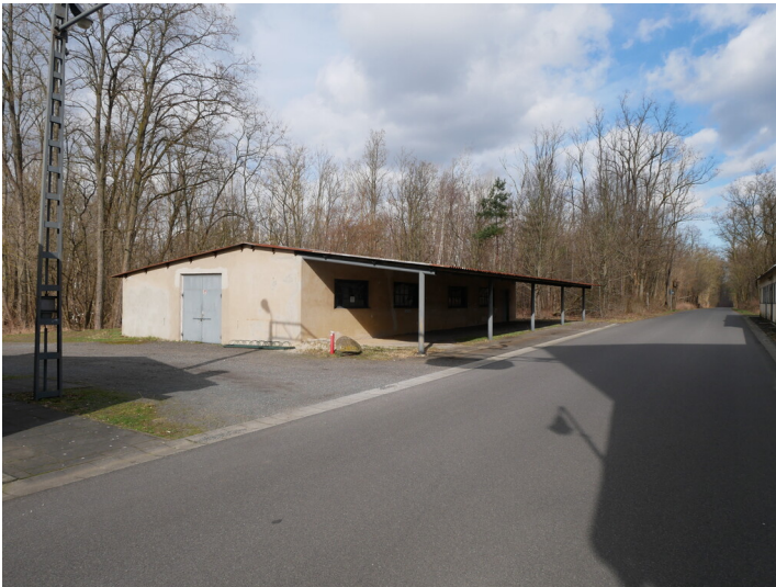
Transmissionswerkstatt der Brikettfabrik Louise Fotograf/Urheber: Kaja Boelcke
