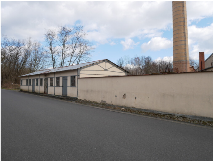
Elektrowerkstatt der Brikettfabrik Louise Fotograf/Urheber: Kaja Boelcke
