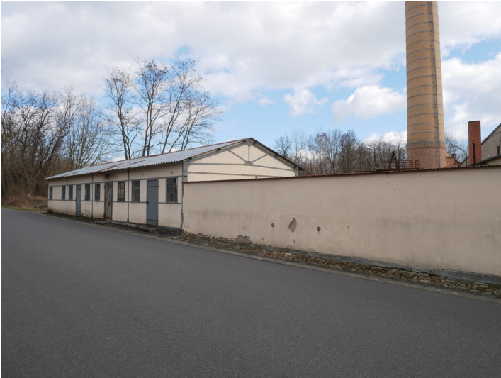
Elektrowerkstatt der Brikettfabrik Louise Fotograf/Urheber: Kaja Boelcke
