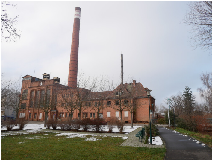
Avellis-Heizwerk Fotograf/Urheber: Tanja Trittel
