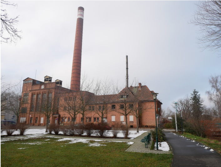
Avellis-Heizwerk Fotograf/Urheber: Tanja Trittel
