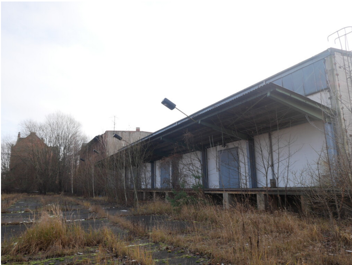
Betriebsbahnhof Stadtbahn Forst, Lagerhaus Fotograf/Urheber: Tanja Trittel
