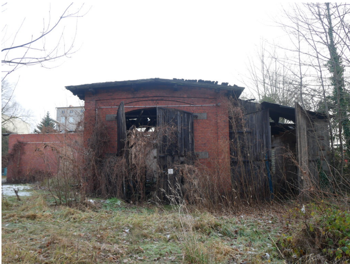
Betriebsbahnhof Stadtbahn Forst, Lokschuppen Fotograf/Urheber: Tanja Trittel
