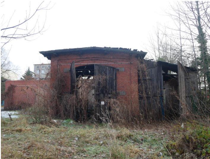
Betriebsbahnhof Stadtbahn Forst, Lokschuppen Fotograf/Urheber: Tanja Trittel
