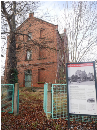
Betriebsbahnhof Stadtbahn Forst, Verwaltungsgebäude Fotograf/Urheber: Tanja Trittel
