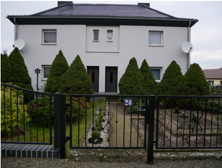
Doppelwohnhaus Bergarbeitersiedlung Dorfstraße Fotograf/Urheber: Dr. Barbara Kündiger
