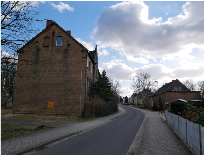
Glashütte Robert Hirsch westlich Forster Straße Fotograf/Urheber: Kaja Boelcke
