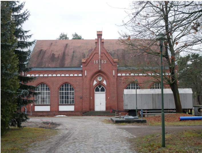
Wasserwerk Forst Fotograf/Urheber: Tanja Trittel
