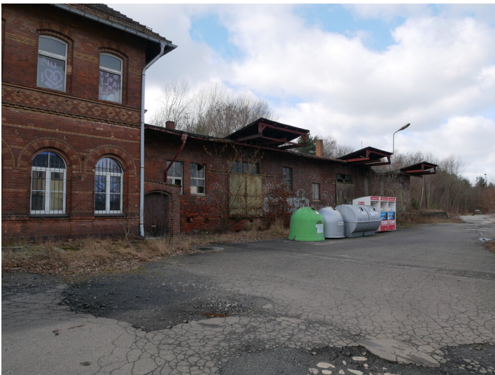
Betriebsgebäude für Schienenverkehr nördlich angrenzend an Empfangsgebäude Fotograf/Urheber: Kaja Boelcke
