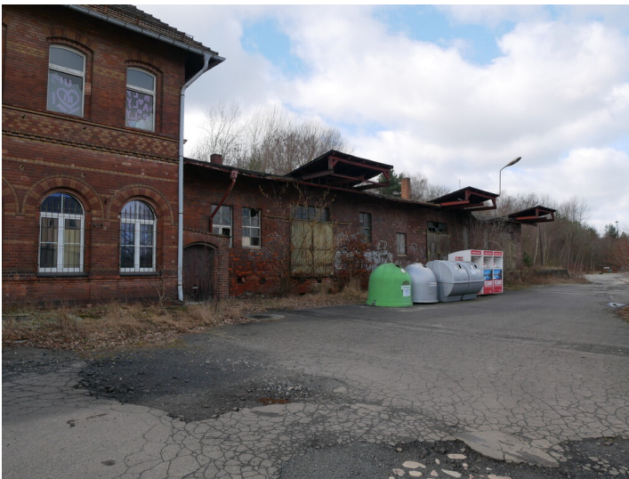
Betriebsgebäude für Schienenverkehr nördlich angrenzend an Empfangsgebäude Fotograf/Urheber: Kaja Boelcke
