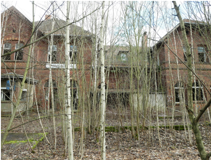
Empfangsgebäude des Bahnhofs Döbern Fotograf/Urheber: Kirsten Krepelin
