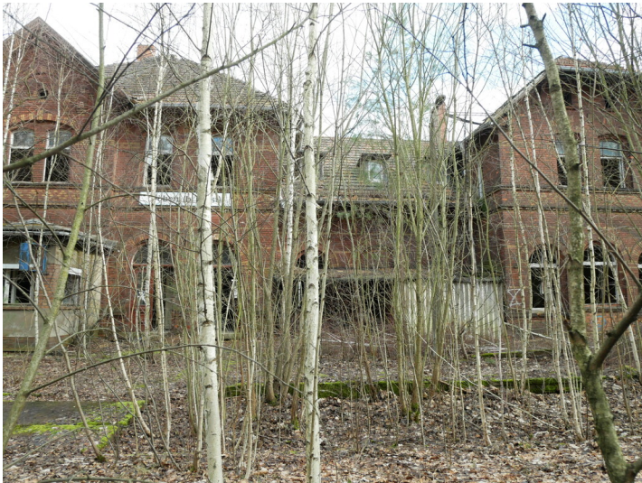
Empfangsgebäude des Bahnhofs Döbern Fotograf/Urheber: Kirsten Krepelin
