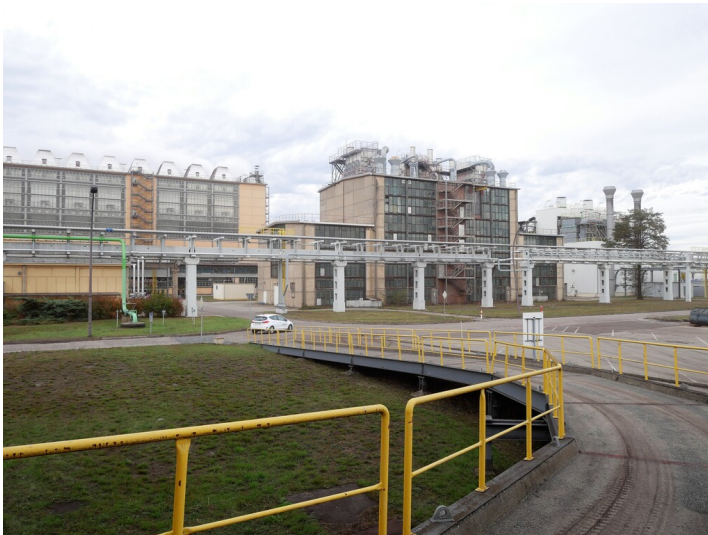
Brikettfabrik Mitte Fotograf/Urheber: Kaja Boelcke
