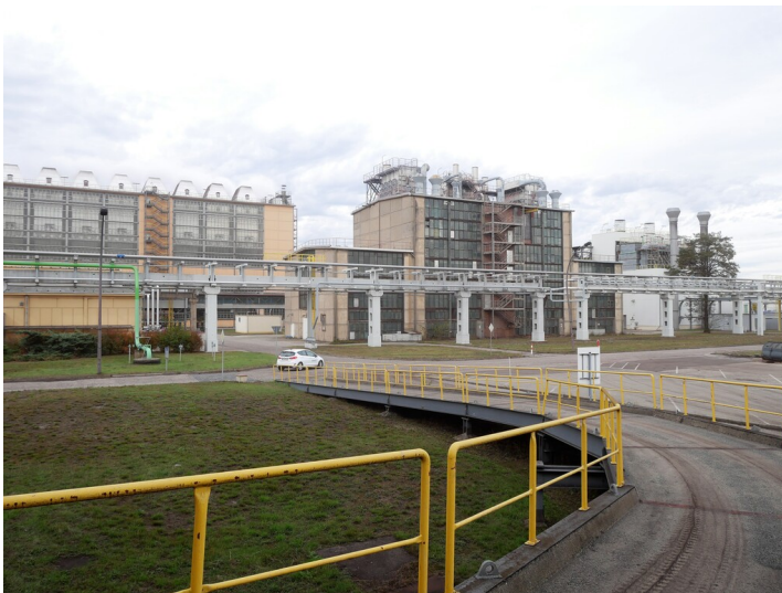
Brikettfabrik Mitte Fotograf/Urheber: Kaja Boelcke
