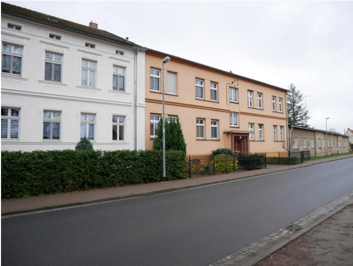
Tuchfabrik Schulze Fotograf/Urheber: Franz Dietzmann
