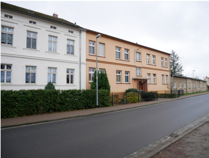
Tuchfabrik Schulze Fotograf/Urheber: Franz Dietzmann
