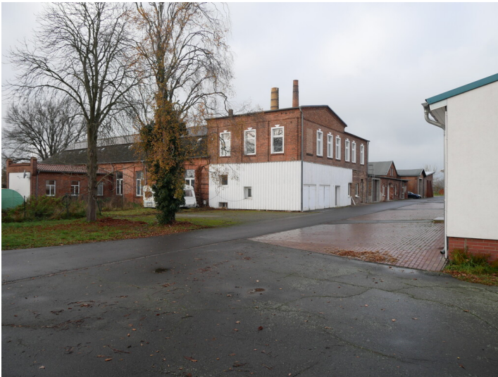
Staussziegel-Gewebe-Fabrik Fotograf/Urheber: Franz Dietzmann
