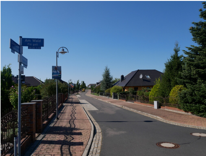
Siedlung Neu-Haidemühl Eigentumsbauten Fotograf/Urheber: Kaja Boelcke
